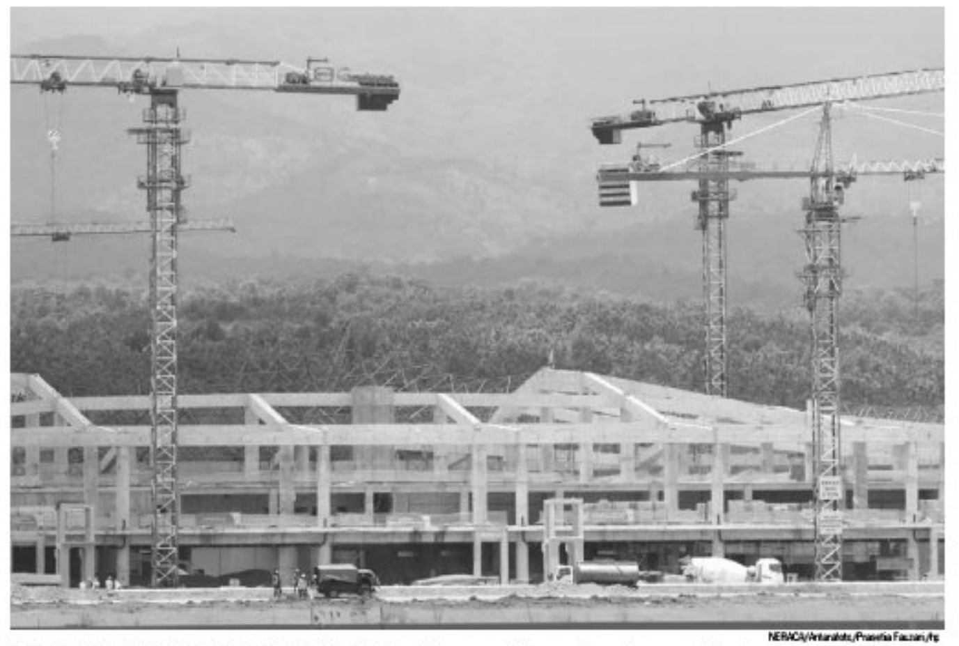
TARGET PENYELESAIAN BANDARA KEDIRI : Alat berat beroperasi di proyek pembangunan Bandara Doho di Kediri, Jawa Timur, Senin (6/3/2023). Proyek strategis nasional bandara pertama di Indonesia yang dibangun dengan pembiayaan swasta mulai menggunakan anggaran pendapatan belanja negara dengan nilai total investasi mencapai Rp10,8 triliun tersebut ditargetkan selesai pada akhir tahun 2023.
